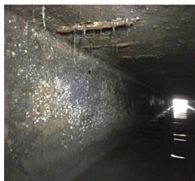
Eine veraltete Kanalisationsinfrastruktur in Verbindung mit starker Korrosion und den negativen Auswirkungen des Hurrikans Sandy führte zu einer umfassenden Sanierung und strukturellen Wiederherstellung.
