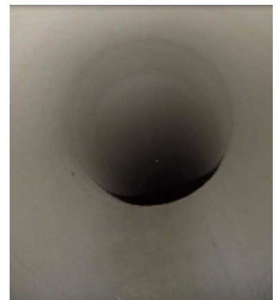
Druckrohrleitung nach der GeoKrete®-Anwendung.
