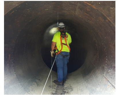
Blick auf den steilen Hang der Druckrohrleitung hinunter.
