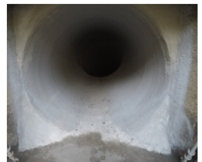
GeoKrete Liner - Strukturelle Erneuerung und Wiederherstellung der Fließfähigkeit.
