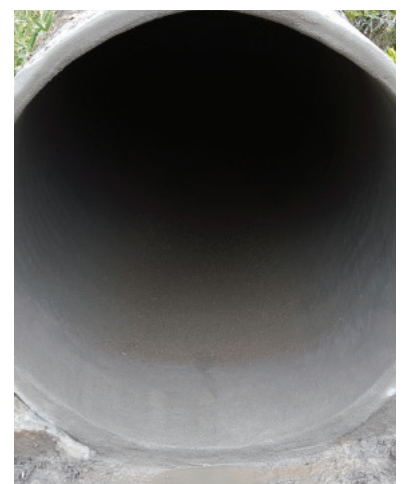
QLS GeoKrete wurde im Schleudergussverfahren angewandt, um eine glatte, strukturelle und korrosionsbeständige Oberfläche zu erhalten.
