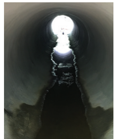
QLS GeoKrete wurde aufgespritzt und anschließend gespachtelt, um eine glatte, gleichmäßige Dicke zu erreichen.
