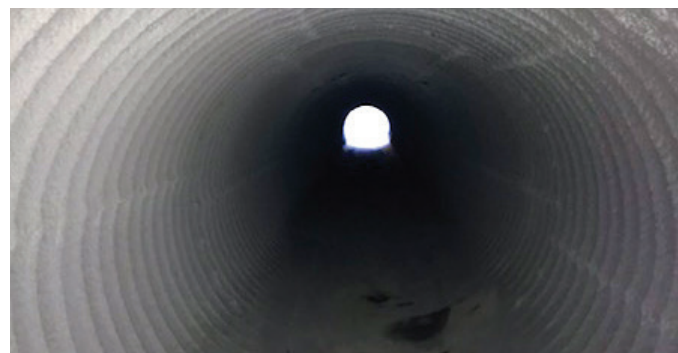
Metallwellrohr saniert mit dem Quadex Auskleidungssystem
