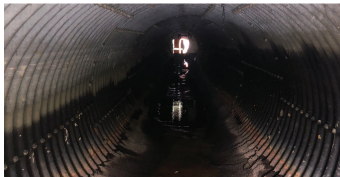
Beeinträchtigt 228 cm-Metallwellrohr
